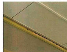
シャッター全開時
